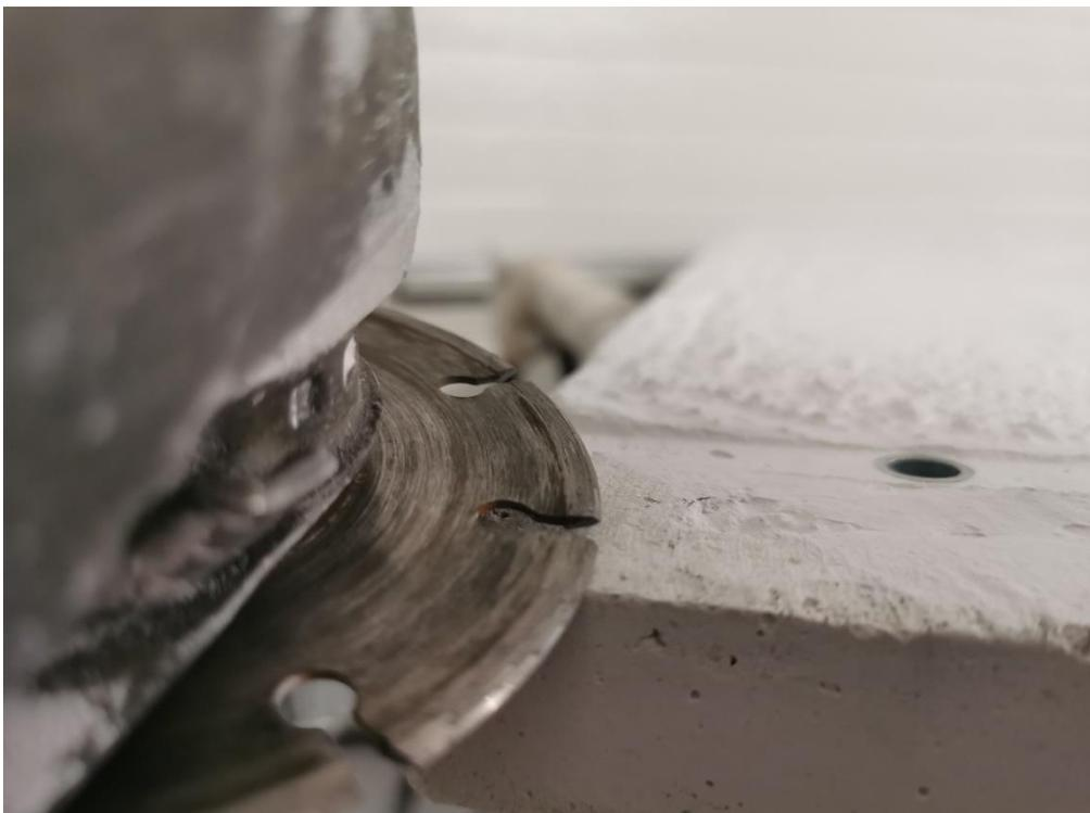
Ziehen Sie die Schrauben mit Gefühl leicht an (max. 1Nm!). **Diese sollten fest sein, aber auf keinen Fall mit hoher Kraft festgezogen!** Arbeiten Sie nach diesem Motte: „Geben Sie dem Bausatz etwas Freiheit zu arbeiten, sich bei Temperaturen zu bewegen.“ Stahl dehnt sich aus, wenn er wärmer wird. Deshalb ist grundsätzlich wichtig, nie hohe Kraft oder gar Gewalt bei der Montage anzuwenden!
