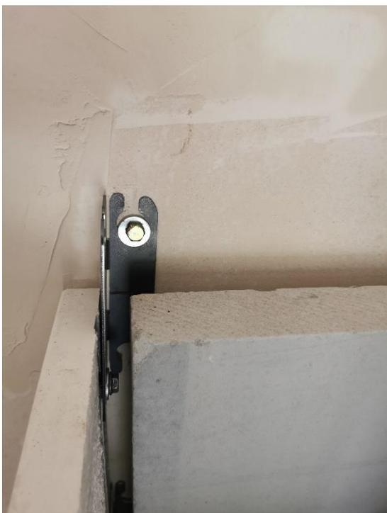
Lassen Sie bereits beim Aufbau den Blendrahmen montiert. So gelingt es Ihnen besser, die Platten sauber auszurichten:
