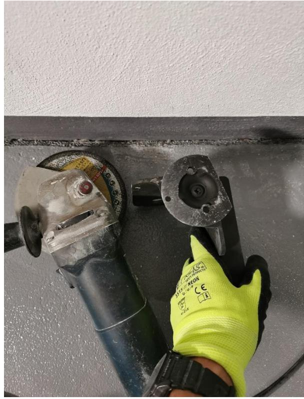
Es empfiehlt sich, jede Platte bereits vor dem Einbau etwas zu schleifen. Achten Sie dabei darauf, dass die Platte flach auf einem Tisch liegt. **Die Platte darf niemals nur auf seinen äußeren Enden hingelegt werden**, da sie durch das hohe Eigengewicht brechen könnte. Unter der Platte müssen immer eine Tischplatte oder z.B. Holzlatten liegen:.
