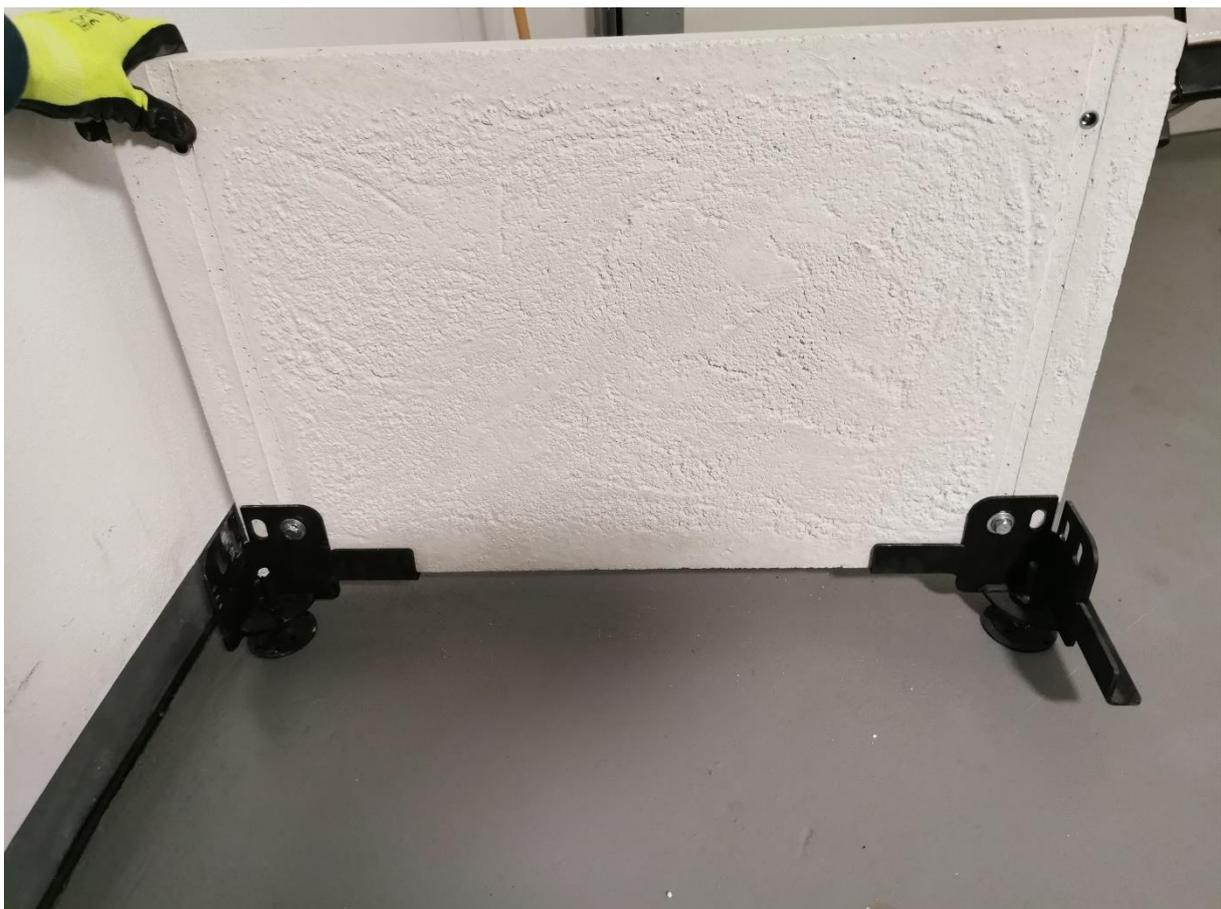
Achten Sie darauf, dass die Frontplatte vor die seitlichen Platten gesetzt wird.
