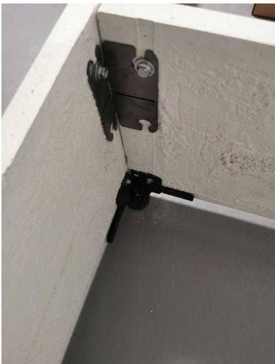
**Haben Sie die unterste Ebene zusammengeschraubt, dann schieben Sie diese vor den Kamineinsatz um den Kamineinsatz auszurichten. Tasten Sie den Kamineinsatz so an seine perfekte Position an. Anschließend dürfen Sie diesen rauchgasseitig und ggfs. wasserseitig anschließen.**
