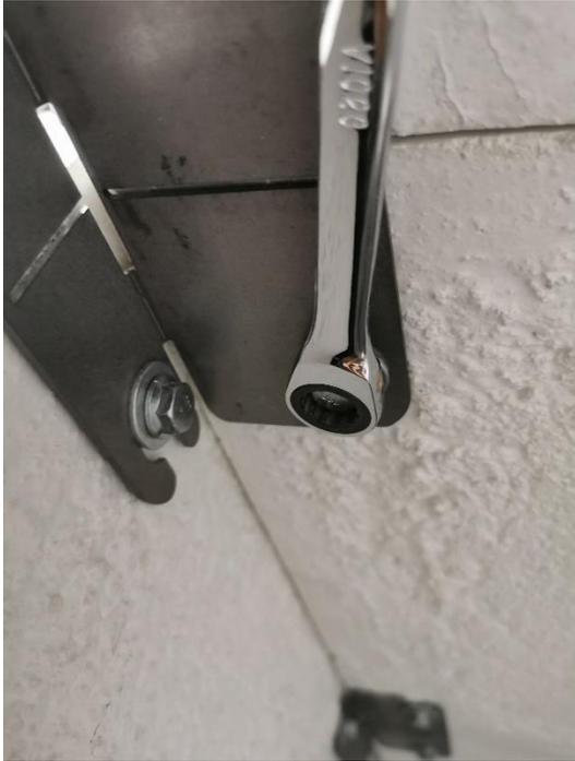
Theoretisch dürfen Sie jede Ebene rückwandseitig an der Hauswand festschrauben. Schrauben Sie aber mindestens eine Ebene, z.B. die dritte, oben fest.
