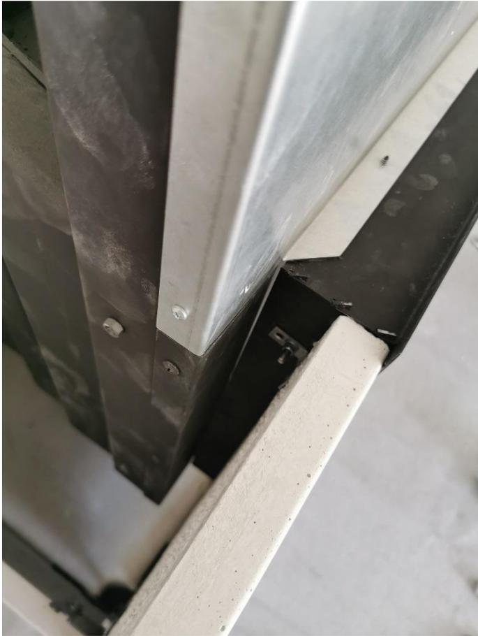
Insbesondere bei Lift-Eckmodelle ist eine die Verschraubung der unteren Ecke nicht gut erreichbar. Verlängern Sie dazu Ihren Schraubenschlüssel um die Schraube anzuziehen:
