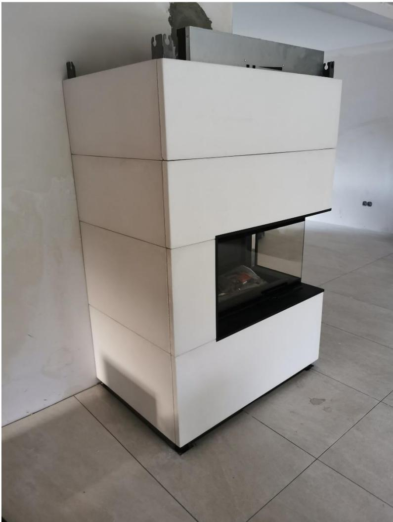
Dabei ist es sehr wahrscheinlich, dass Sie innere Kanten nachfeilen oder mit einem Winkelschleifer mit Diamantscheibe nachschleifen müssen, damit dies Platten ein einheitlicheres Fugenbild ergeben.
