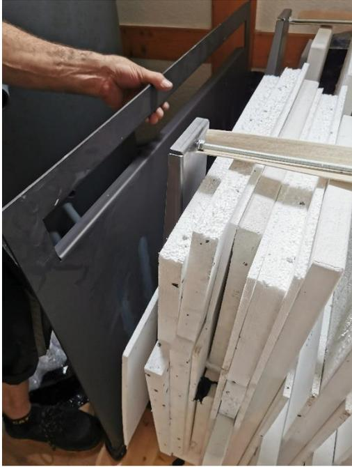
Setzen Sie die Füße des Kamineinsatzes ein. Diese liegen in der Regel im verpackt im Brennraum. Stellen Sie den Kamineinsatz an seinen Aufstellort und richten diesen grob aus.
