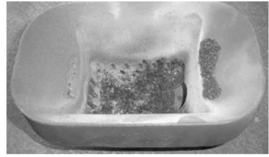
BEISPIEL VERSCHMUTZTE BRENNSCHALE
