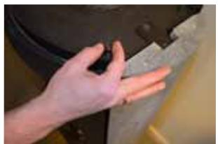
**4:** Montieren Sie die 4 oder 5 Spezialmuttern, die mit dem Heat-Storage-Kit mitgeliefert werden (Artikelnr. 08-423).
