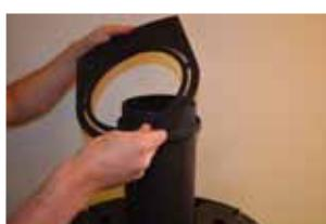
**10:** Si vous installez le poêle avec un conduit de fumée arrivant par le haut, et que vous souhaitez raccorder le conduit AVANT de terminer l'installation du poêle, n'oubliez pas de monter la grille supérieure. – Elle NE POURRA PAS être montée par la suite ! Montez le conduit en dernier.
