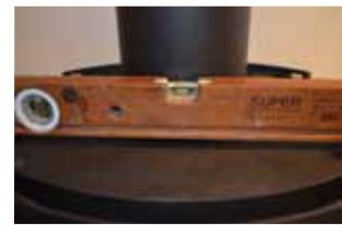
**7:** Assurez-vous que le poêle est bien de niveau. Montez/réglez au besoin les 4 pieds sous le poêle, de façon à stabiliser ce dernier. **ATTENTION ! Il doit rester au minimum 8 mm d'espace sous le poêle si jamais vous souhaitez monter une plaque de verre TermaTech.**
