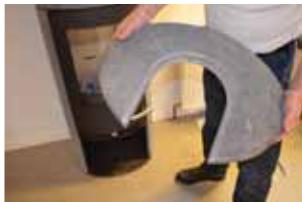
**22:** Montieren Sie den oberen Speckstein.
