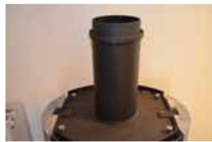
**5:** Si vous souhaitez une évacuation par le haut, démontez le conduit d'entrée au sommet du poêle, et montez le tuyau fourni. N'oubliez pas les joints entre le tuyau et le poêle. Remontez ensuite le conduit d'entrée par dessus le tuyau, n'oubliez les joints entre le tuyau et le conduit d'entrée.
