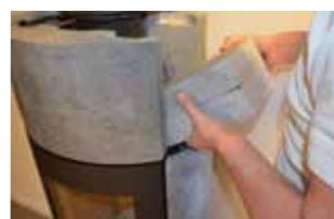
**17:** Démontez ensuite une des pièces de verrouillage sur le dessus du poêle et retirez précautieusement le bloc latéral correspondant.
