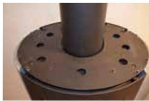
**8:** Mettez en place la plaque d'acier sur les 4 ou 5 vis spéciales sur le dessus du poêle.
