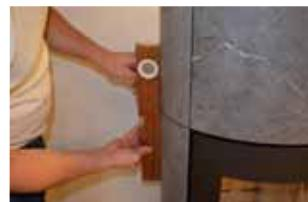
**16a:** Desserrez les blocs latéraux un par un, et ajustez-les de façon à bien les aligner avec le bloc supérieur. Revissez ensuite le bloc en question.
