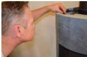
**21:** Insérez les vis dans les pièces de verrouillage. Vissez-les en butée de façon à ce que les blocs soient en contact et d'équerre.
