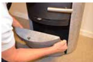
**24:** De steen met de pakkingzijde naar beneden voorzichtig in de verbrandingsruimte monteren en de pen aan de bovenkant naar beneden drukken zodat deze zich kan vastzetten in het gat op de ribben. Deze handeling zorgvuldig uitvoeren.
