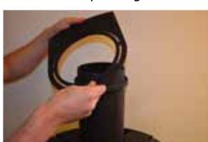
**10:** Als u op de houtkachel een stalen rookanaal installeert en dit wilt installeren VOORDAT u klaar bent met de installatie van uw houtkachel, moet u niet vergeten het rooster bovenop te installeren. - Het KAN NIET achteraf worden geïnstalleerd! Het rookanaal als laatste installeren.
