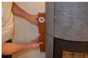
**16a:** Lockern Sie immer einen Seitenstein einzeln und richten Sie diesen so, dass er auf einer Linie mit dem oberen Stein ist - ziehen Sie hierauf die Seitensteine wieder fest.
