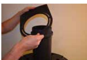
**10:** Sofern Sie Ihren Ofen mit einem Stahlschornstein oben etablieren und den Schornstein VOR der Endmontage des Ofens installieren möchten, vergessen Sie bitte nicht, den Gitterrost oben zu montieren. Dieser kann nachträglich NICHT montiert werden! Montieren Sie den Schornstein zuletzt.
