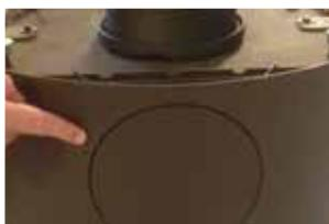
**6:** Als u een afvoer aan de achterzijde wilt, verwijder dan het gietijzeren pijpstuk bovenop de kachel. De platen achter op de ommanteling en het hittescherm dienen voorzichtig te worden losgemaakt. De afdekplaat die op de kachel is gemonteerd, dient via de verbrandingskamer te worden verwijderd en bovenop de kachel te worden gemonteerd in de plaats van het gietijzeren pijpstuk. Het gietijzeren pijpstuk dient aan de achterzijde van de kachel te worden gemonteerd. Denk aan de pakking.
